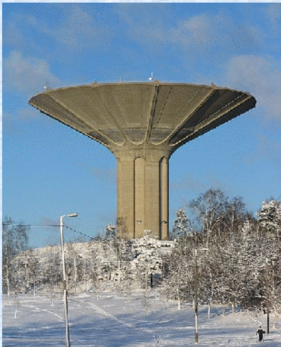
Водонапорная башня типа “golf-ball-on-a-tee”
